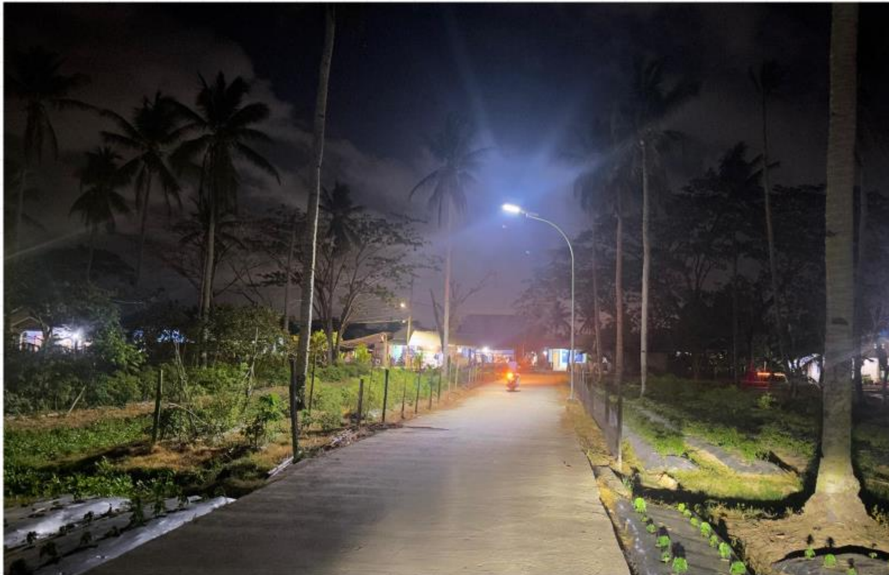
PENERANGAN JALAN UMUM
